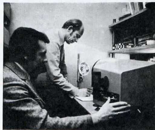
Айн Тукк (слева) и Тауно Ного проводят испытания рефлектора новой студийной фотовспышки
